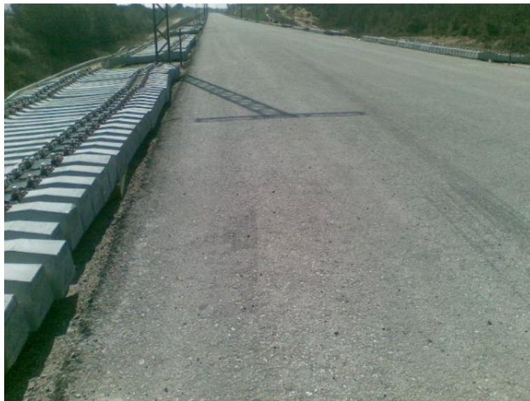
Foto 3: Subbalasto asfáltico extendido en uno de los tramos experimentales.
